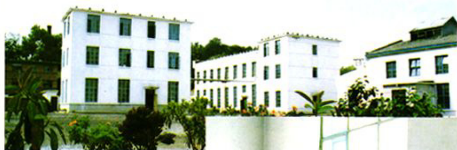
现中试车间外景
