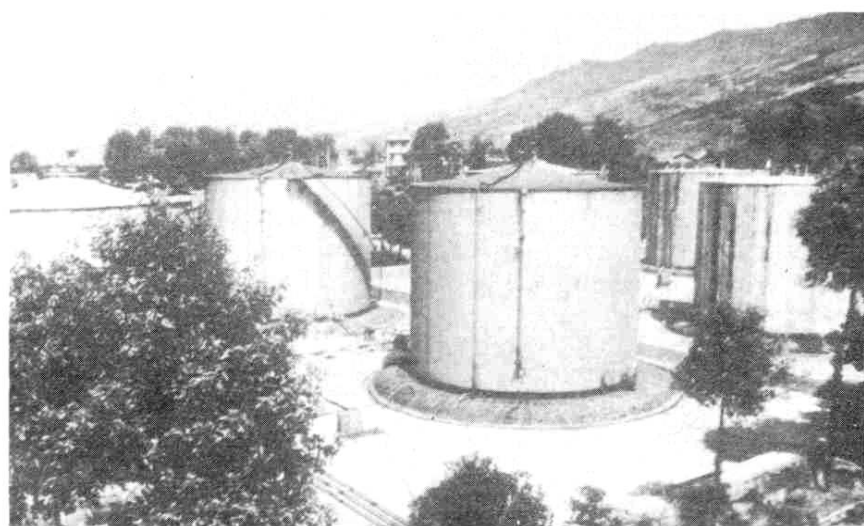
广元石油站油库
