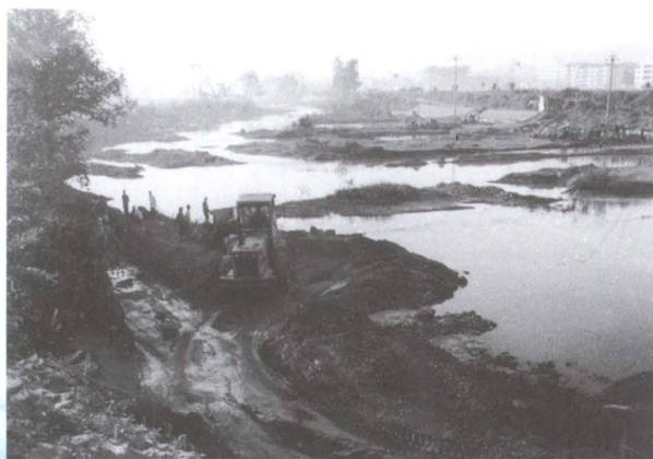
1991年6月浦阳江河道整治工程
