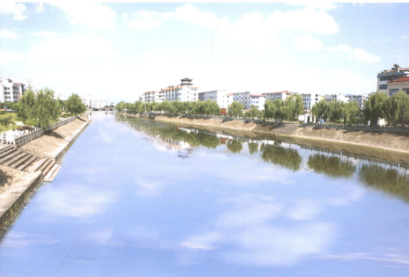
2004年4月整治后的浦阳江河道和堤岸
