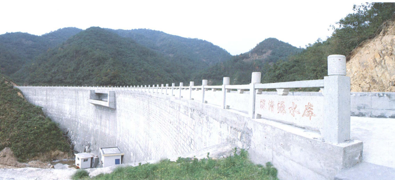
2008年10月建成虞宅乡深清源水库大坝
