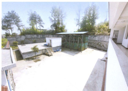
周西坞水库自来水厂调节池
