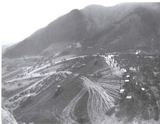
1978年秋金坑岭水库库区建设现场
