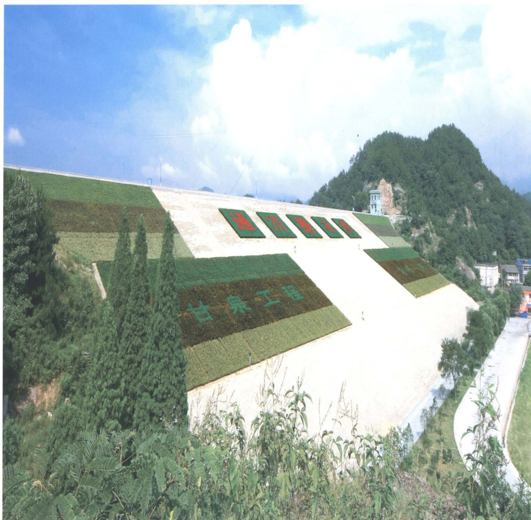
2007年3月除险加固竣工通济桥水库大坝
