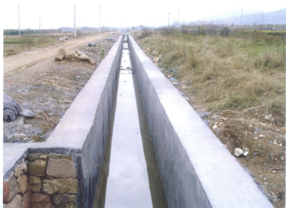
2005年10月通济桥水库南干渠加固竣工的七二线
