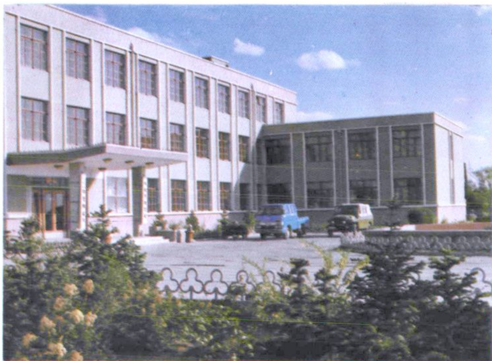
物资(局)供应处机关办公楼
