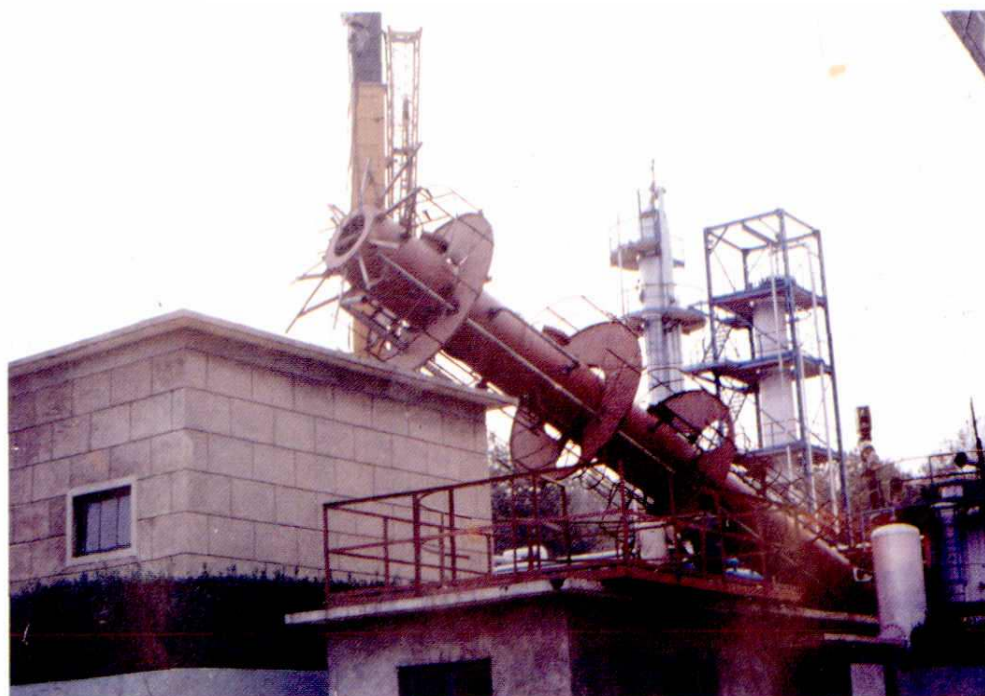
吊装炼油厂循环氢脱硫塔
