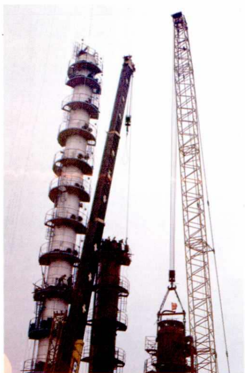
正在施工中的气体 丙——丙分离塔
