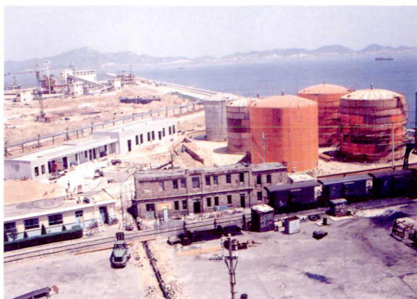
公司承建烟台港油品出口码头
