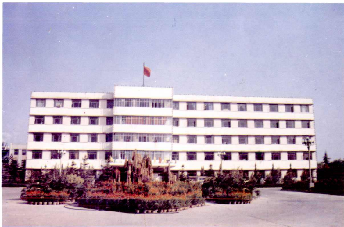
检修公司办公楼
