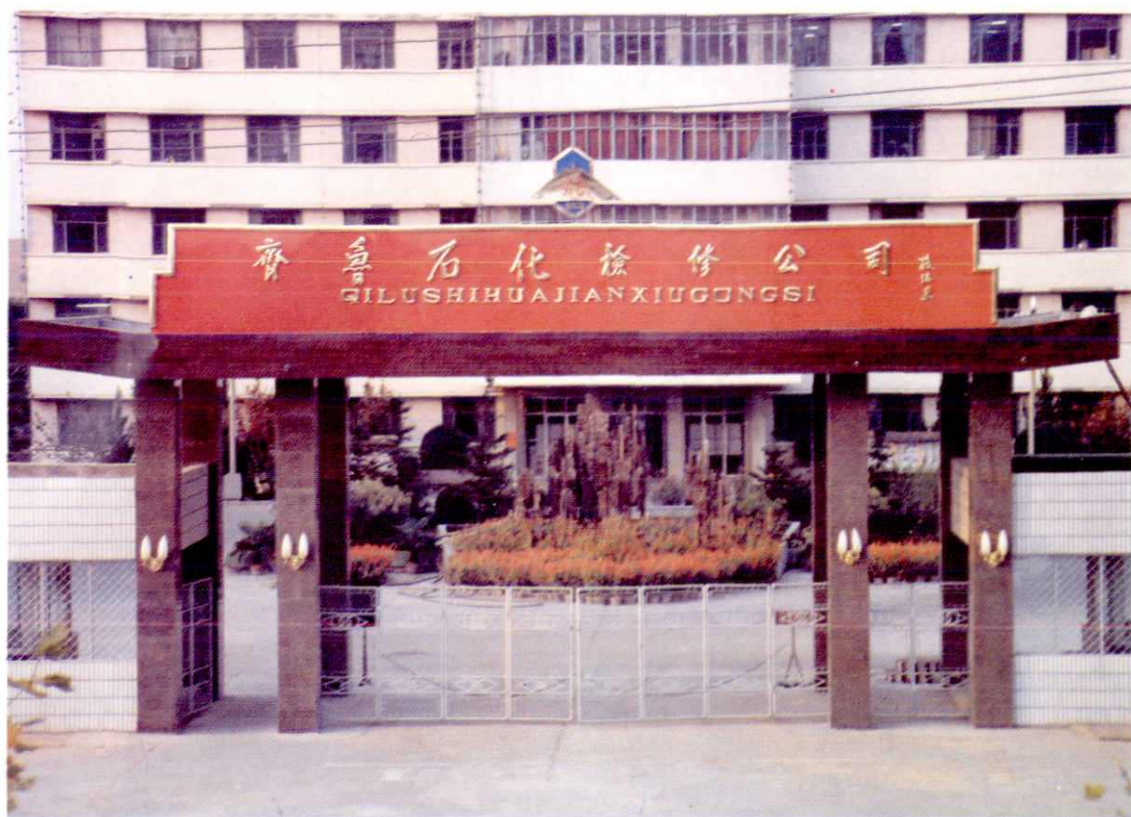
齐鲁石化公司检修公司
