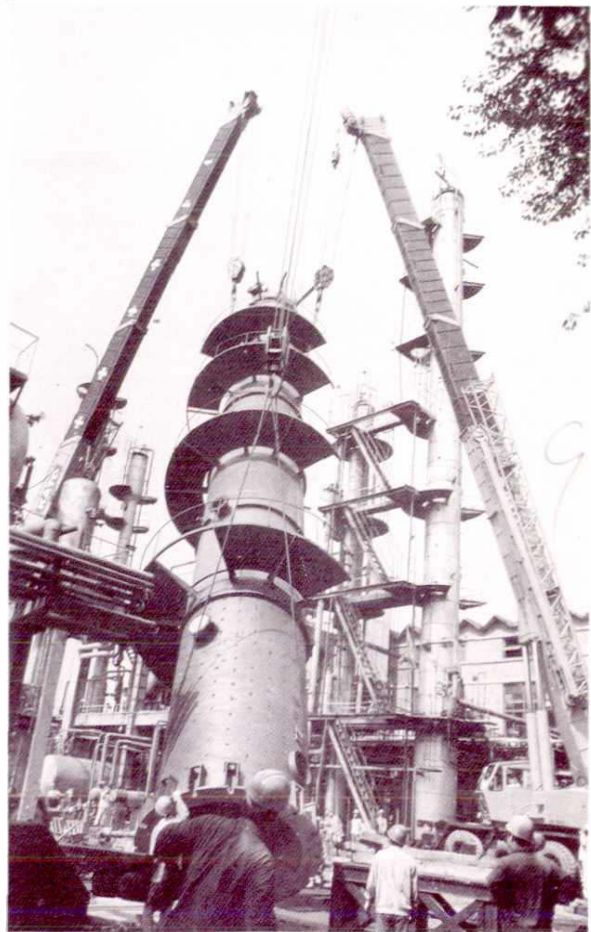
正在吊装的 炼油厂烷基 化塔
