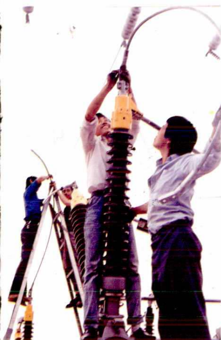
橡胶厂110KV变电站改造增容
