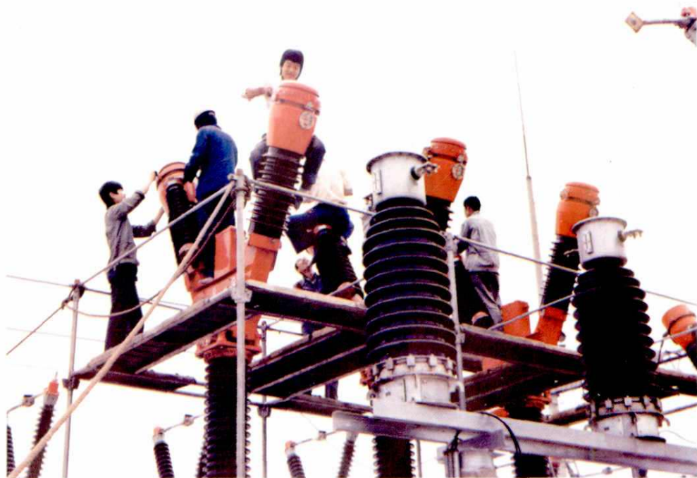
在橡胶厂110KV变电站施工
