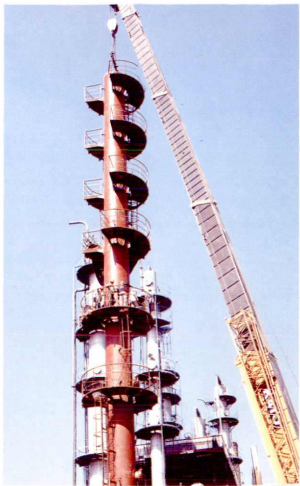
吊装橡胶厂03主项装置塔
