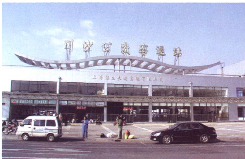
川沙公交客运站
