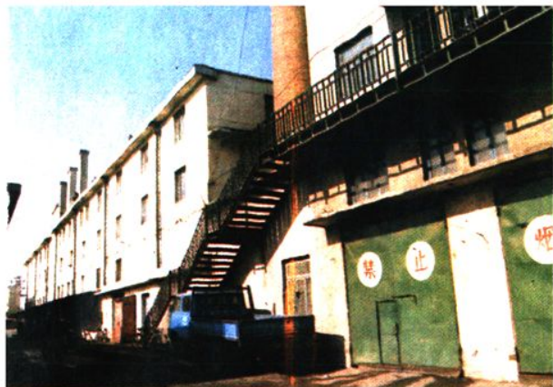
沈阳电务大修段段址
