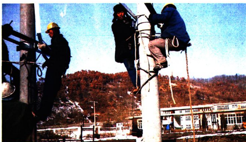
電務職工在現場組裝 電力變壓器臺
