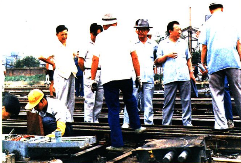
局領導視察電務 大修段施工質量
