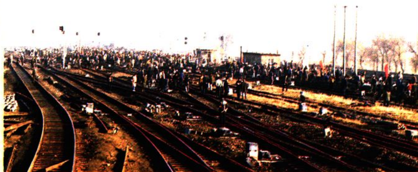
以九小時的時間完成百組 道岔以上站場停電轉綫施工
