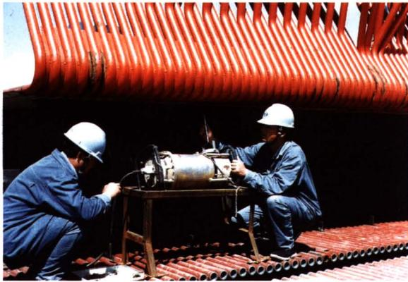
X射线无损探伤锅炉水冷壁焊口
