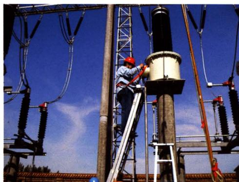
电气升压站瓷瓶套管安装
