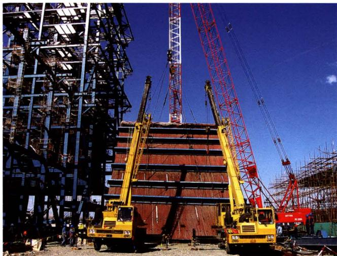
锅炉水冷壁柔性整体吊装
