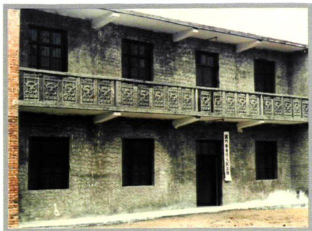
1978年10月，余川人民法庭成立。1986年在松山咀镇自建办公楼，1999年8月，法庭合并至花桥人民法庭。图为余川法庭1986年建成的办公楼。
