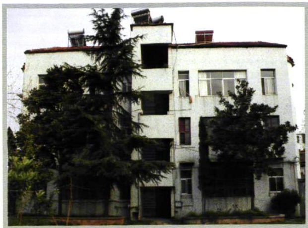
1989年10月，刊江人民法庭成立。1993年在武穴市江家林路自建办公楼，1999年8月法庭合并至武穴人民法庭。图为刊江法庭1993年建成的办公楼。
