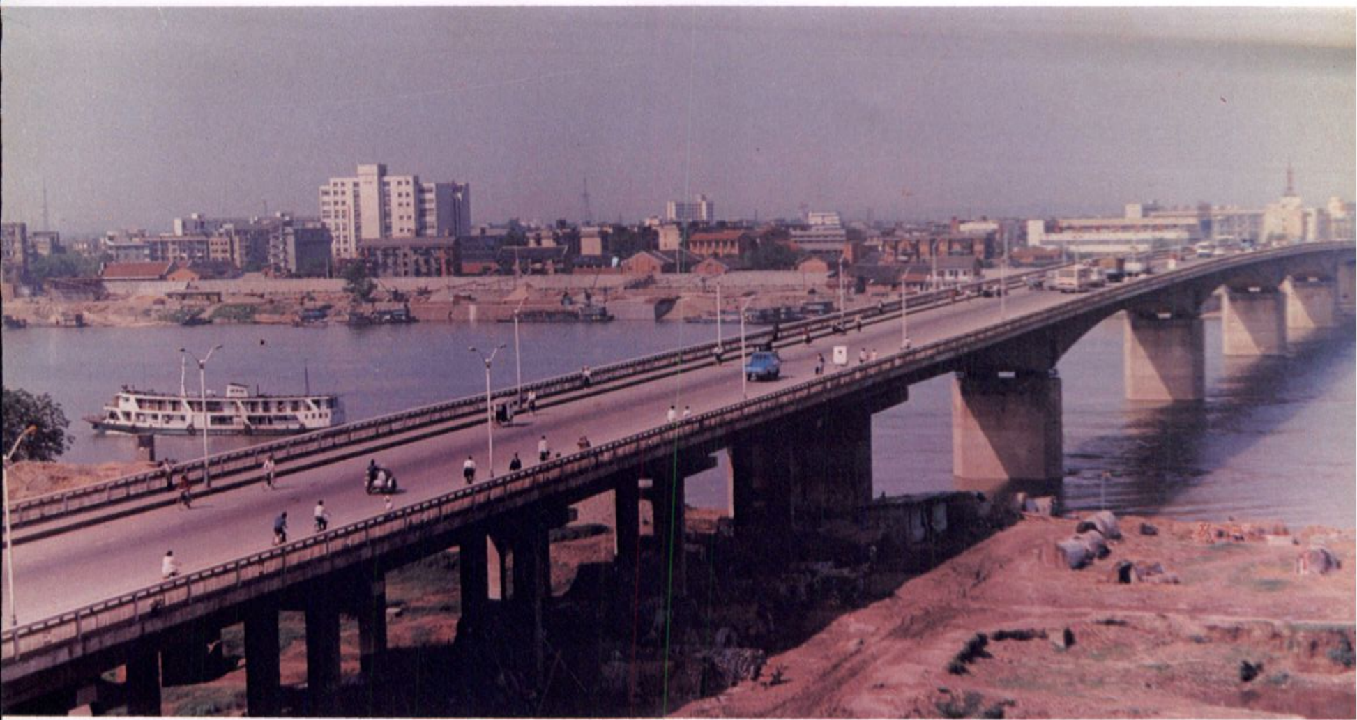
▲常德沅水大桥
