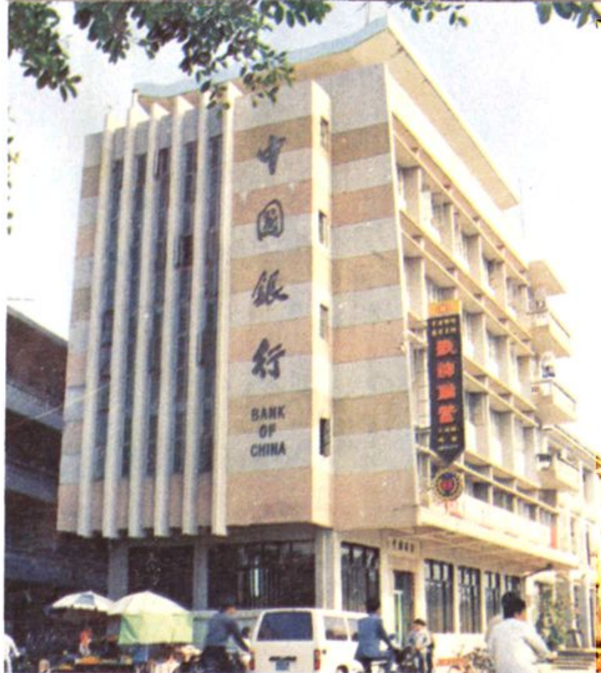
◀ 图为中国银行恩平县支行。行址位于恩城镇沿江路27号。
