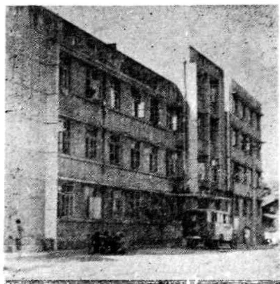
牌木镇卫生院过去房屋十分破旧，现在已经修起新的楼房。
