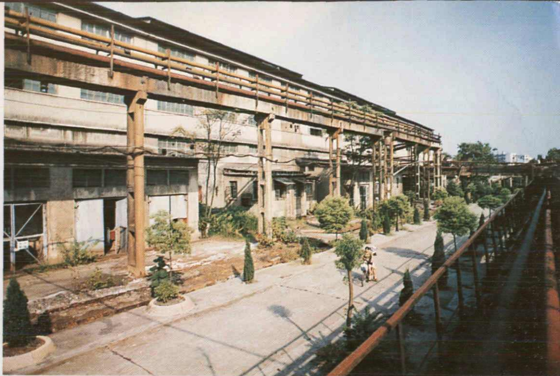
选矿厂主厂房一角
