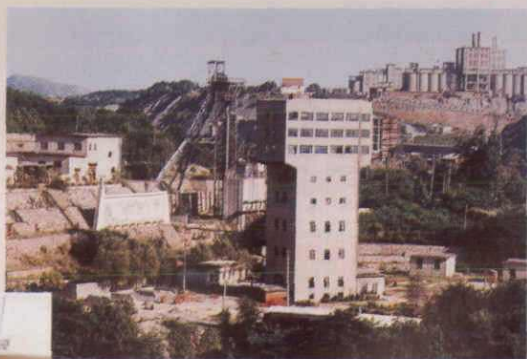
铁门坎地下采场工业场地
