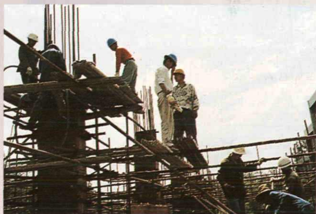
正在施工中的煤气管道支架
