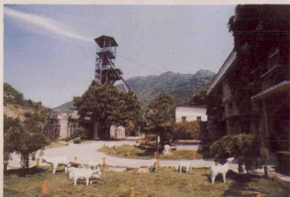
尖林山地下采场主井井架
