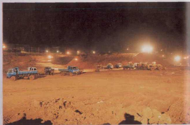
球团厂建设工地夜景
