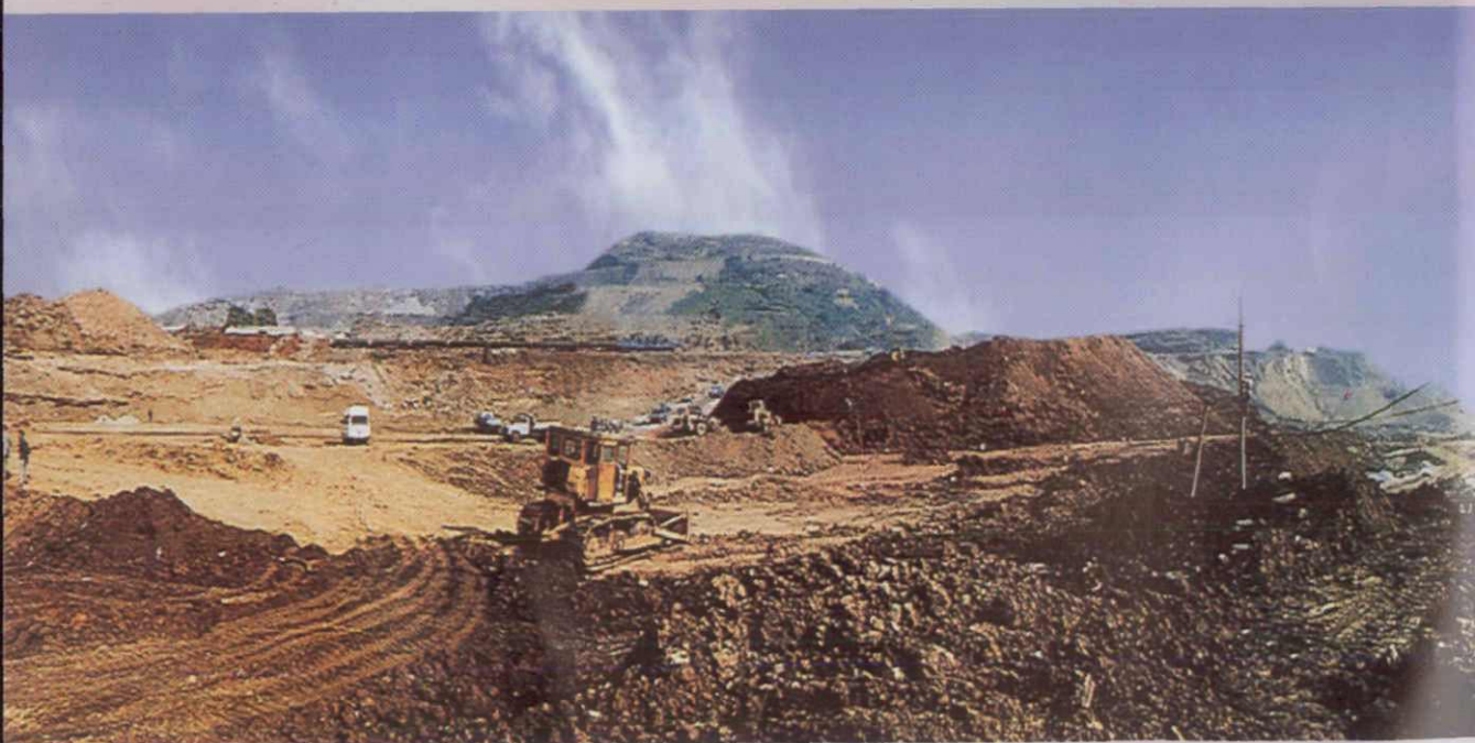
球团厂场平工地
