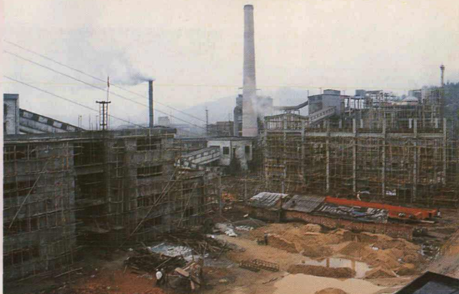
即将竣工投产的竖炉球团厂二期工程厂房一角
