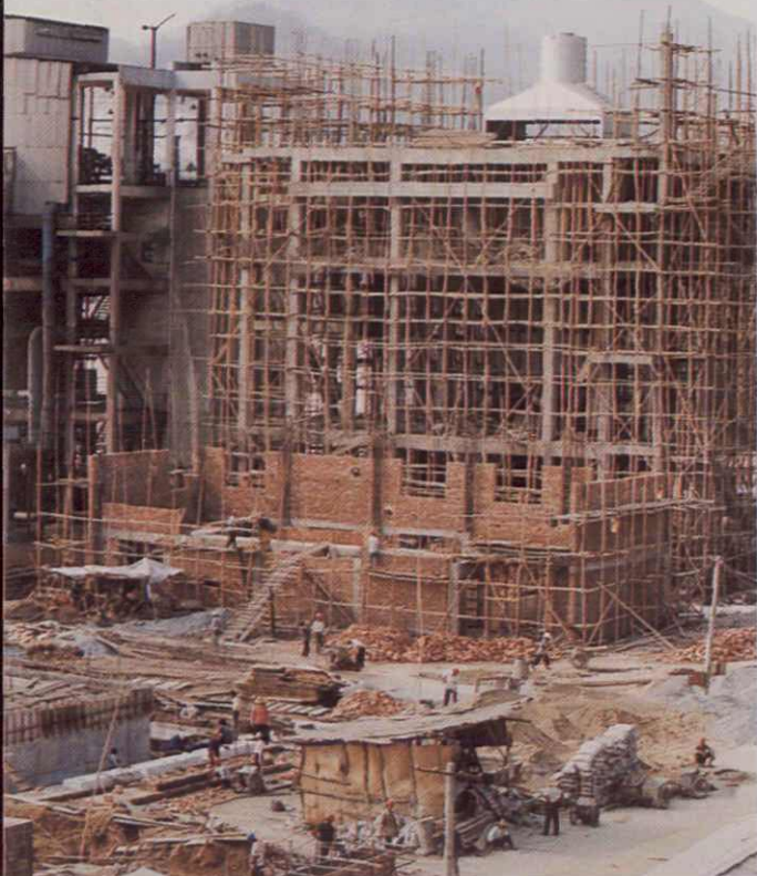
正在建设中的球团厂二期工程竖炉
