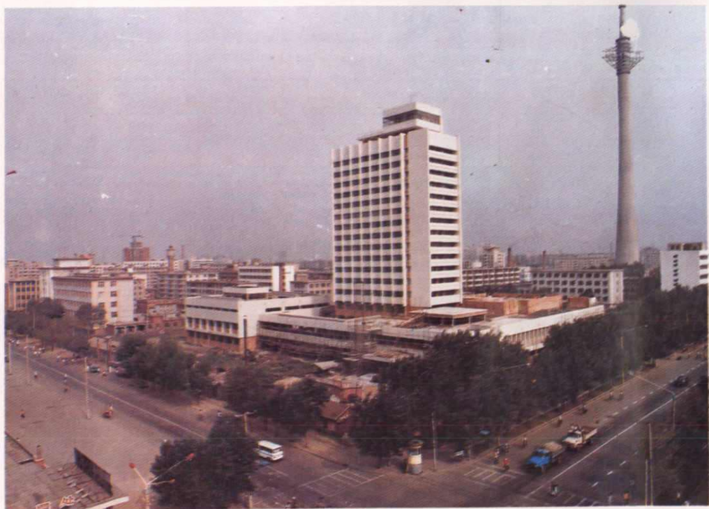
正在建设中的辽宁省科学技术馆（1985年）
