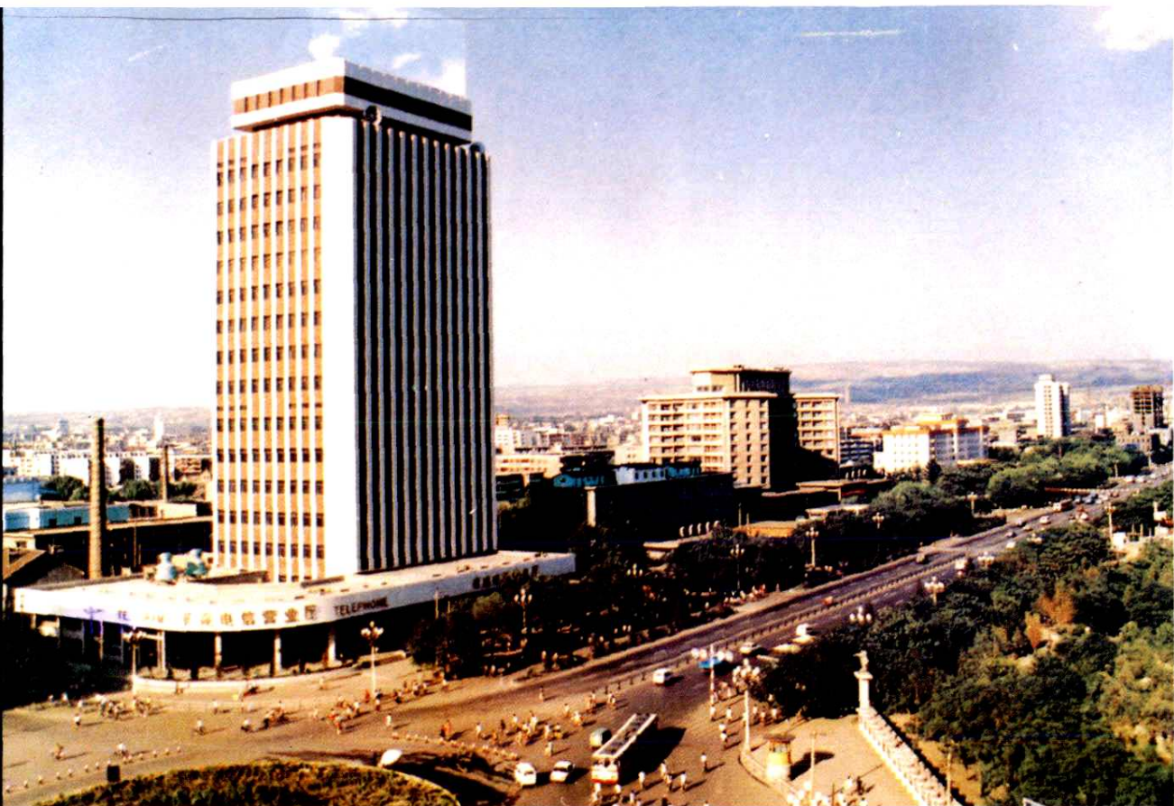
5、太原市电信枢纽大楼
