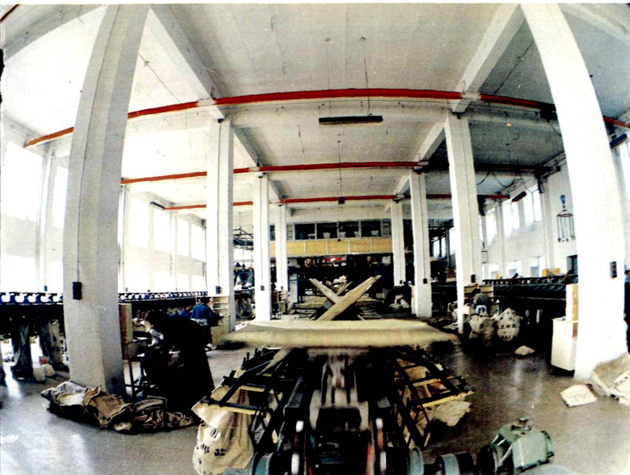
7、太原市邮政枢纽大楼内包裹自动分拣线。
