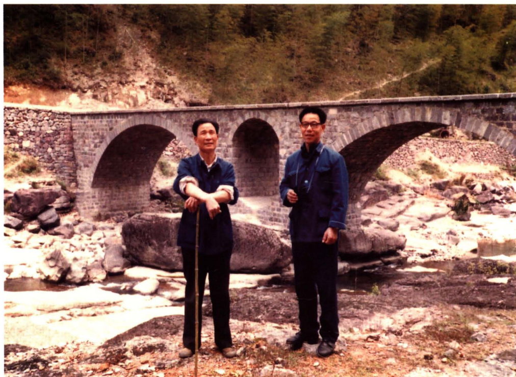
周公宅水库修建前的茅镬大桥
