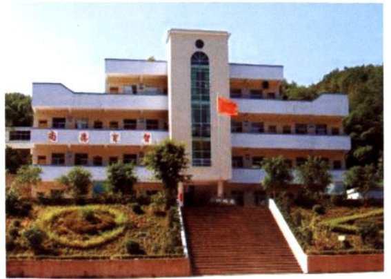
巷口镇青吉小学教学楼
