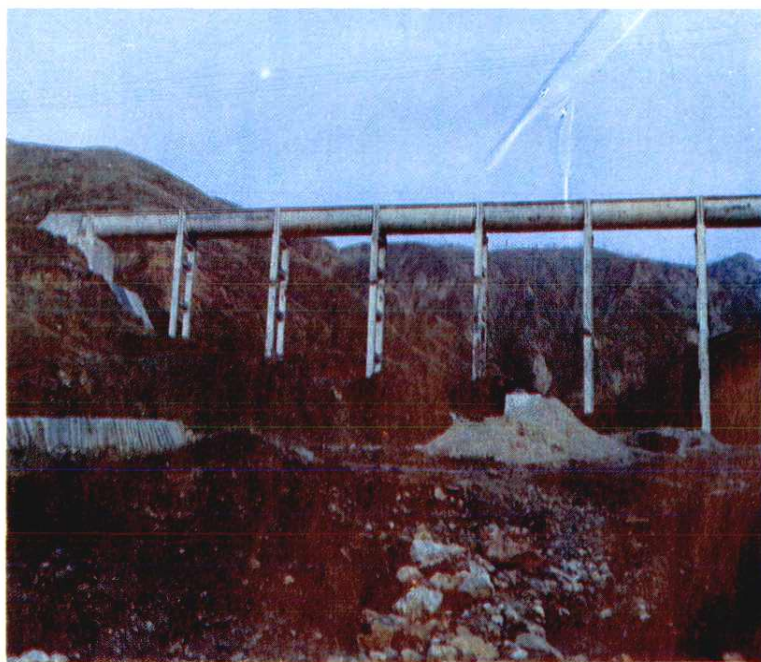
引岱工程：白岩沟渡槽
