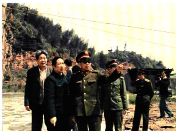
1989年济南军区少将参谋长何美福视察石面坦电站施工现场
