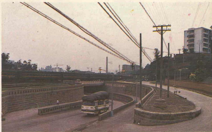
▶ 6. 三八公路铁路立交桥
