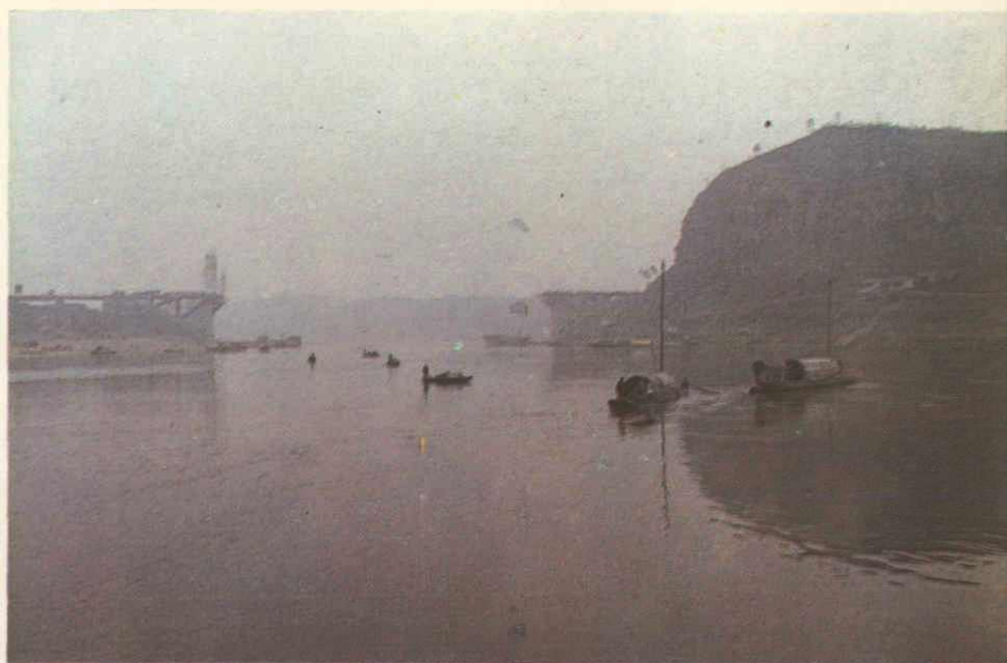
► 18. 建设中的牛佛沱江大桥
