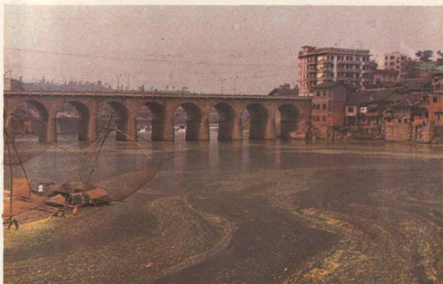
◀ 19. 改建后的邓关大桥
