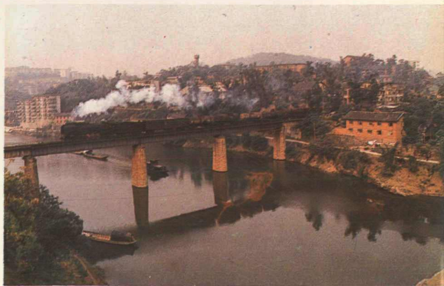
► 20. 东兴寺金溪河立交桥
