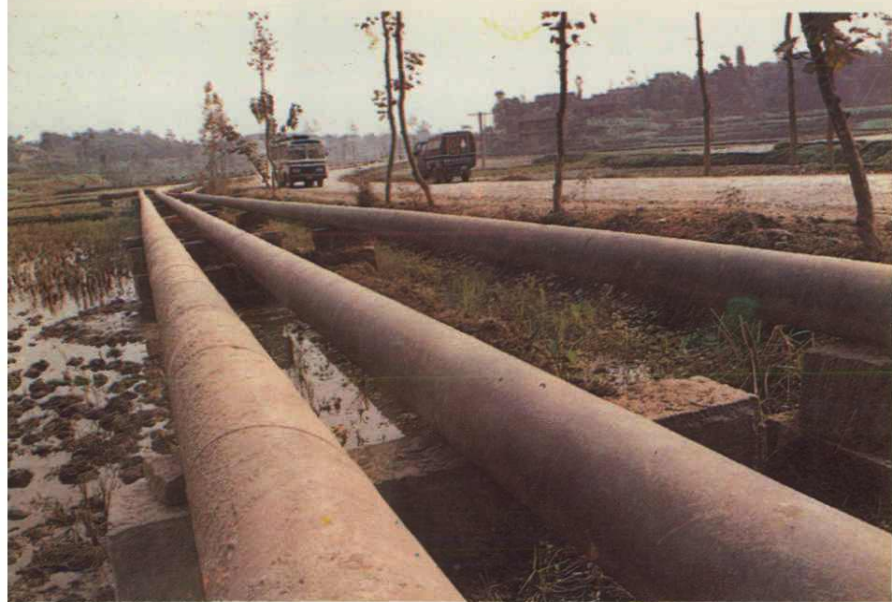
◀ 31. 自贡盐场输卤管道
