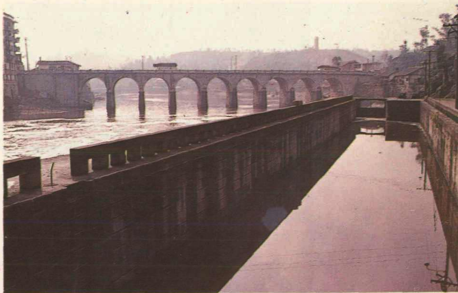
► 28. 釜溪河邓关船闸及邓关大桥
