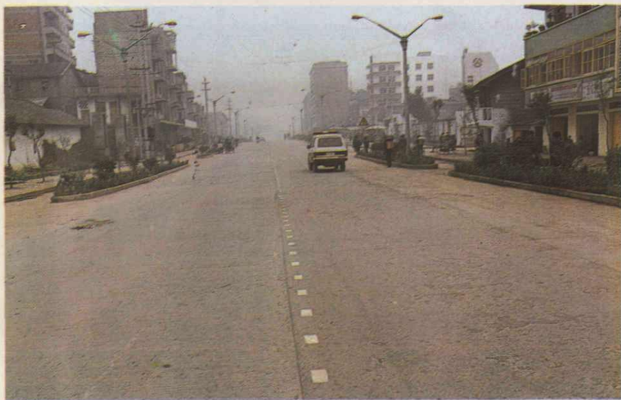
◀ 10. 富顺县城拓宽公路
