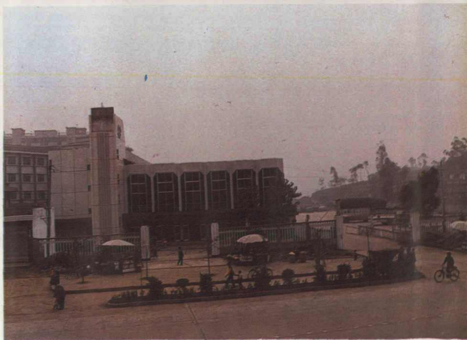
▶ 22. 富顺县客运中心
