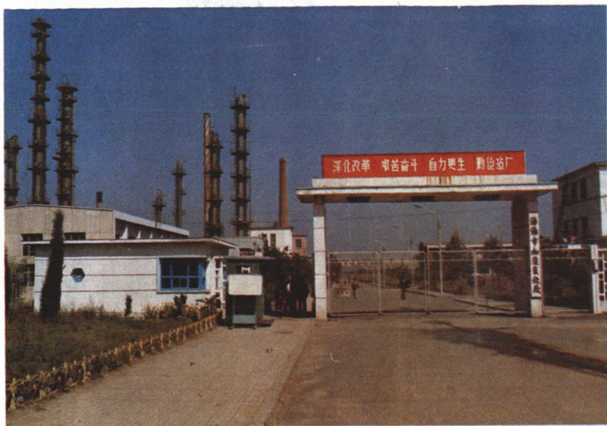
▲ 加压气化厂门景
