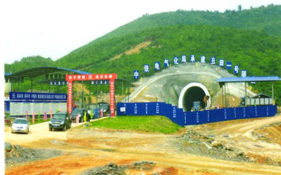
衡茶吉铁路建设工地
