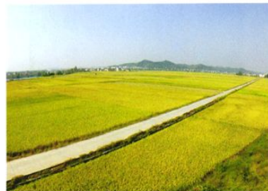
排山乡通村公路
