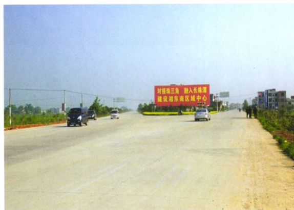
贯穿安仁全境的S212线建设工地
