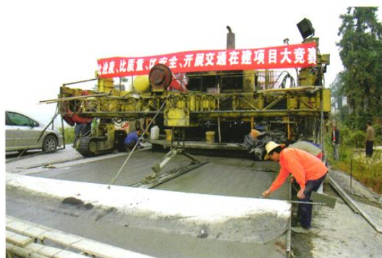
S212线建设工地
