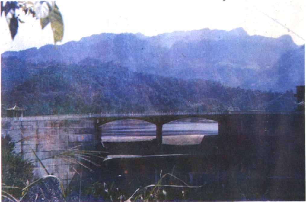
永福县板峡水库大坝一角
