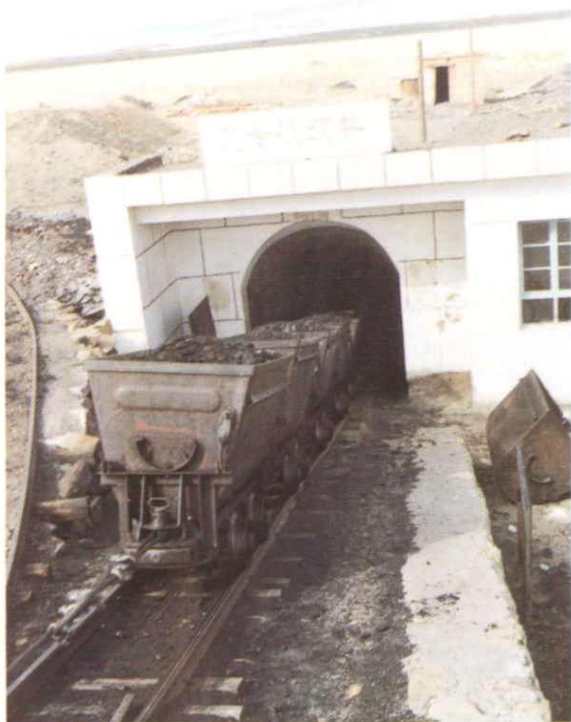
↑ 县煤矿技术改造煤井
