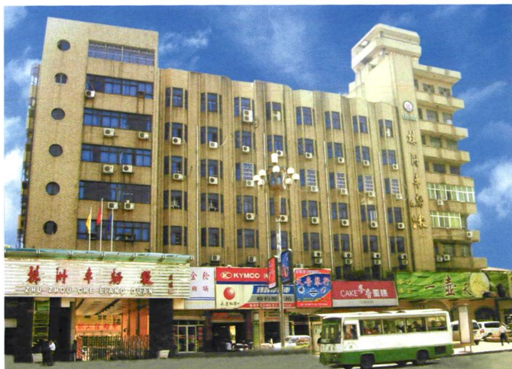
段办公综合大楼
