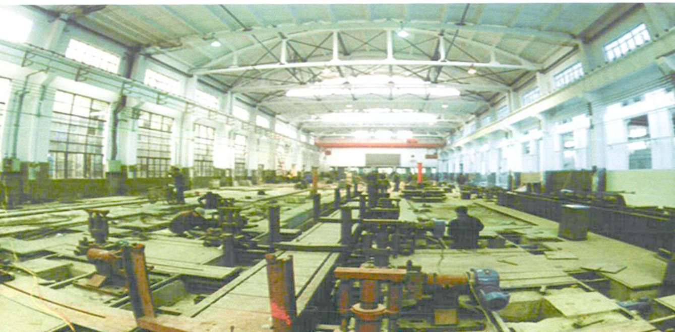
2002年修车库设备正在安装
