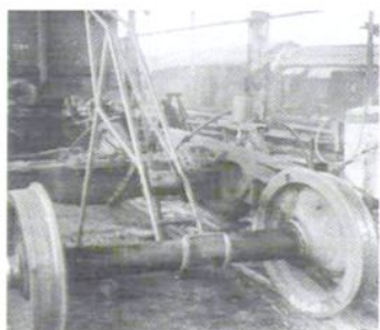
1959 年仅 2 个修车台位,经常 在露天条件下用自制的挂轮镟修车
