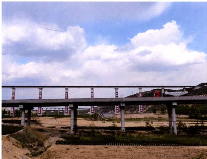
秃尾河采兔沟段大桥
