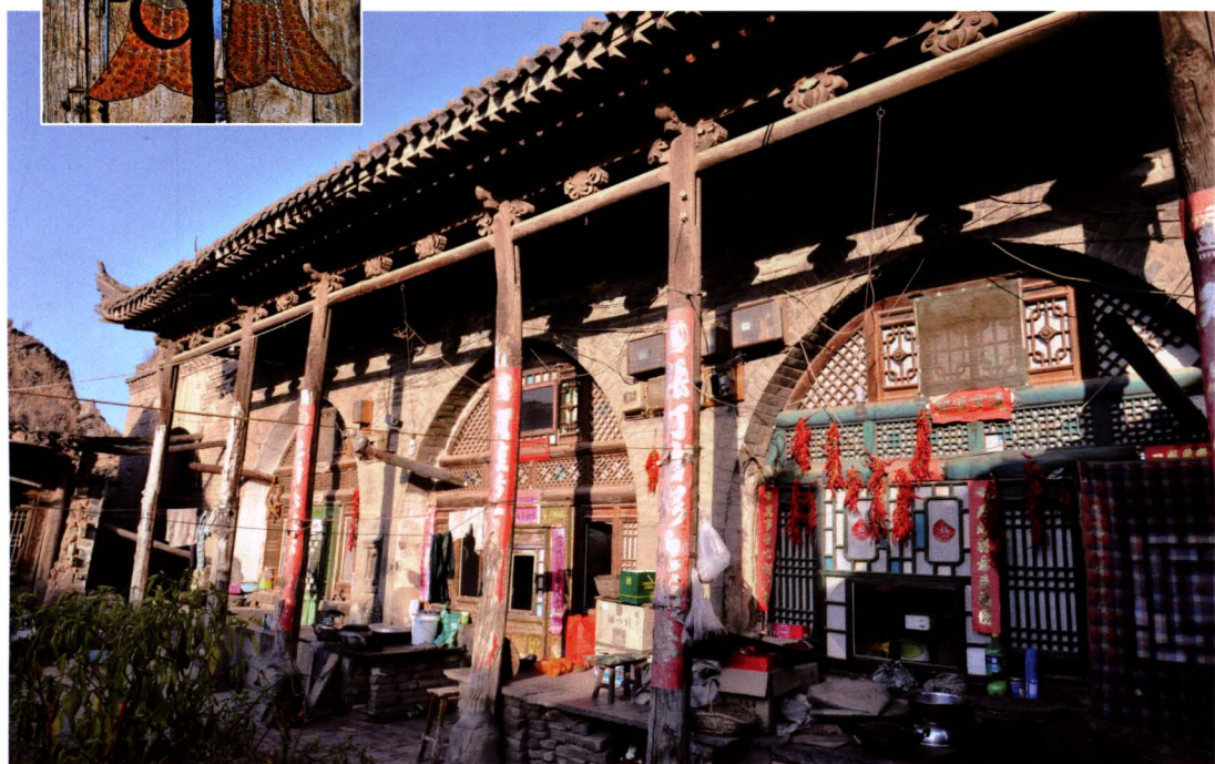
帶有穿廊抱厦的窑洞民居
