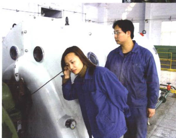
三车间电站工人在认真进行巡检
