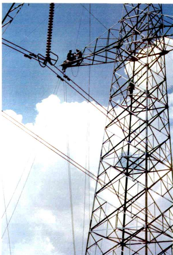
西(安)宝(鸡)公路跨越组塔
