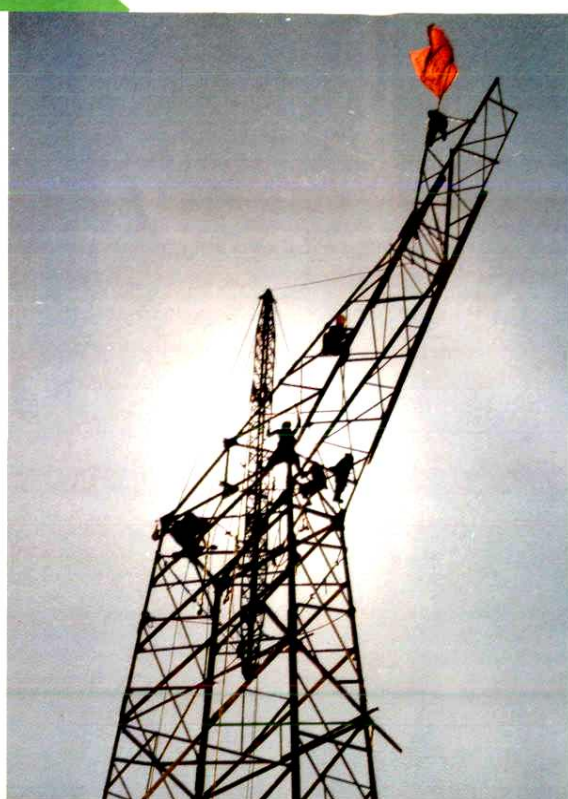
330 千伏渭南—沔河线施工
