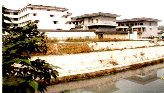
110 千伏西安玉祥门变电站
