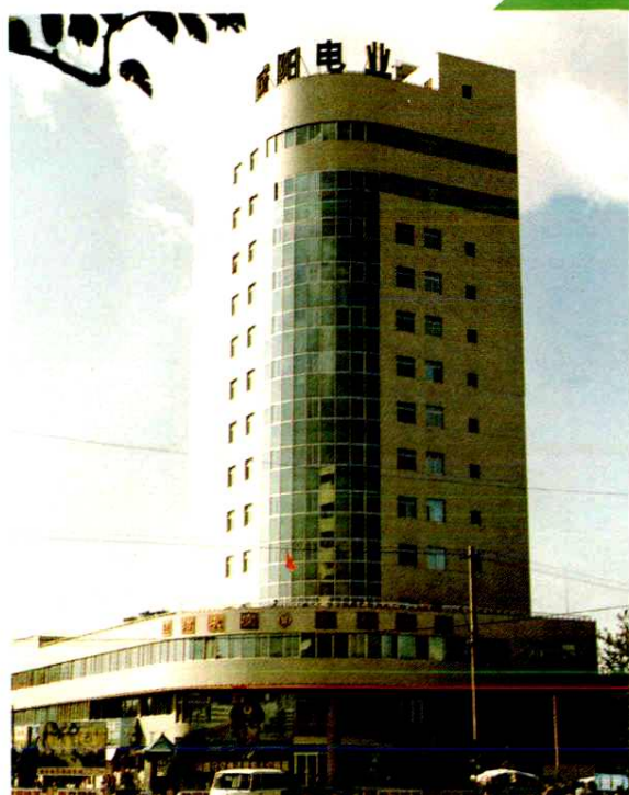
咸阳供电局办公楼
