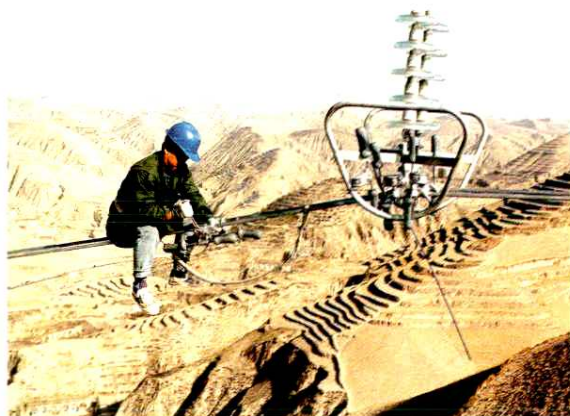
330 千伏金锁关—延安线施工
