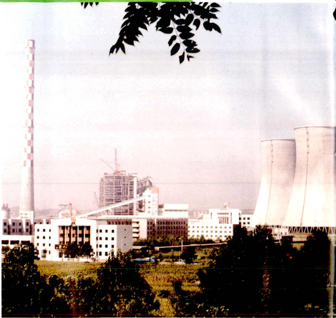
渭河发电厂二期工程 (4×30 万千瓦)
