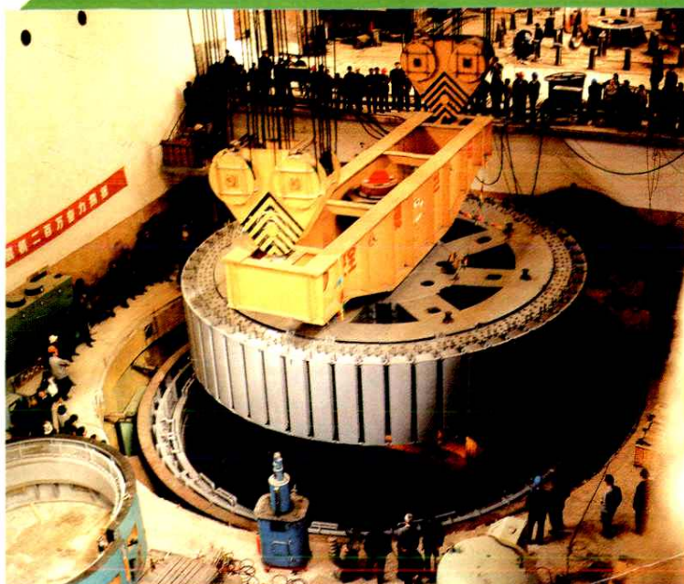
安康水电站 20 万千瓦机组转子吊装 (朱群茂 摄)
