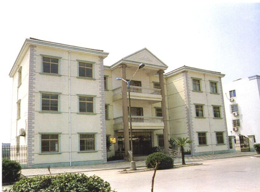
黄桥国土资源所
