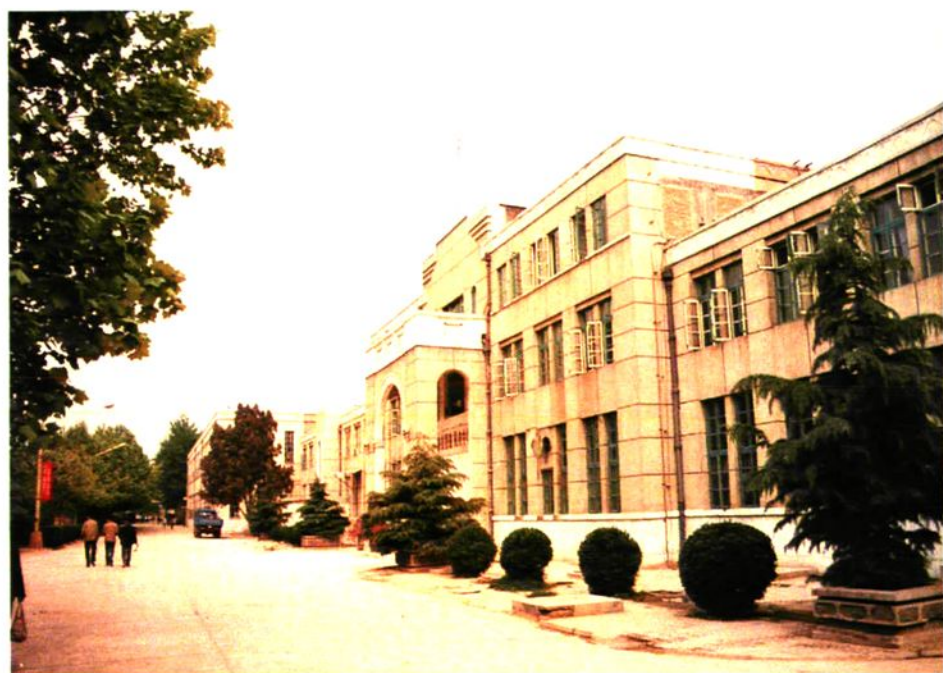
▲厂生产车间主场房一瞥
