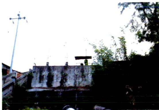
西峡水电站，始建于 1934 年 5 月，原装机 12.5 千瓦； 1964 年扩建后装机 480 千瓦 戚大安摄
