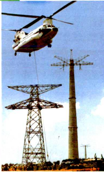
葛洲坝—上海±500千伏输电线工程吉阳 长江大跨越施工中利用直升飞机放线 超高压输变电建设公司提供
