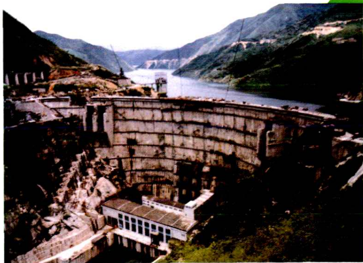
东江水电站，装机 50 万千瓦，首台机组 1987 年 10 月投产 湖南省电力工业局提供
