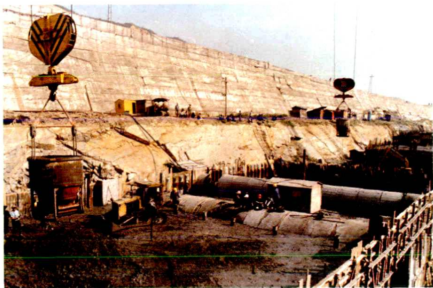
五强溪水电站，总容量 120 万千瓦，1990 年大坝通仓薄层浇筑现场
