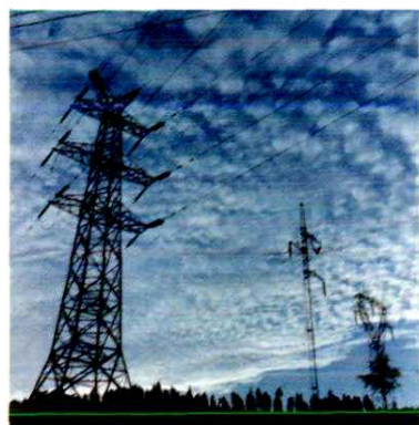
220 千伏丹江口—武汉 输电线路 1969 年 7 月投运
