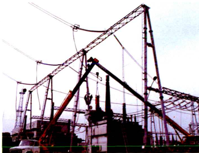
500 千伏武昌凤凰山变电站主变压器有载调压油箱吊芯检修
