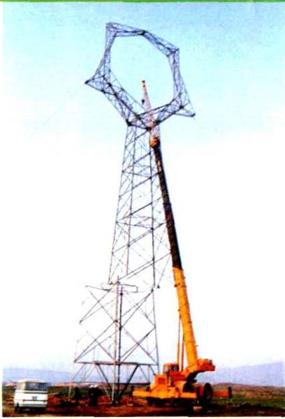
1980年，500千伏平顶山—武昌 输电线施工中采用45吨吊车吊装铁塔 华中电网画册编辑小组提供
