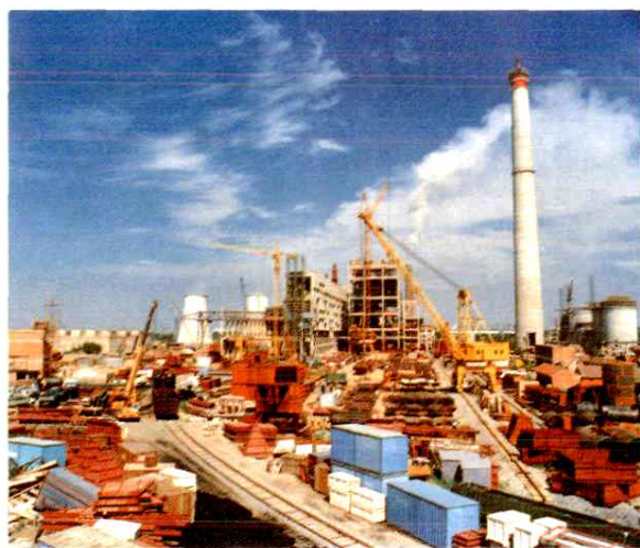
中外合资扩建的郑州热电厂施工现场 河南省电力工业局提供
