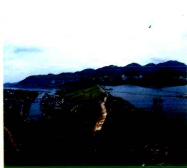
柘林水电站，装机18万千瓦， 首台机组1972年8月投产
