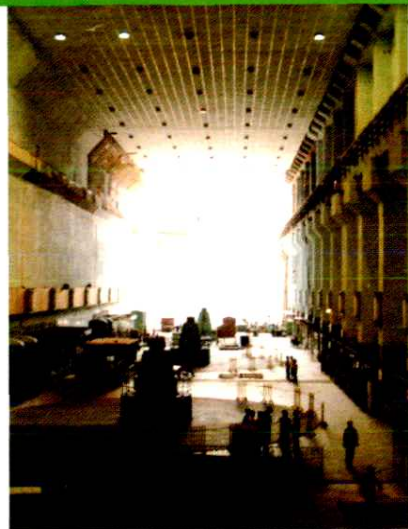
万安水电站，装机 40 万千瓦， 首台机组 1990 年 11 月投产 李喜乐摄
