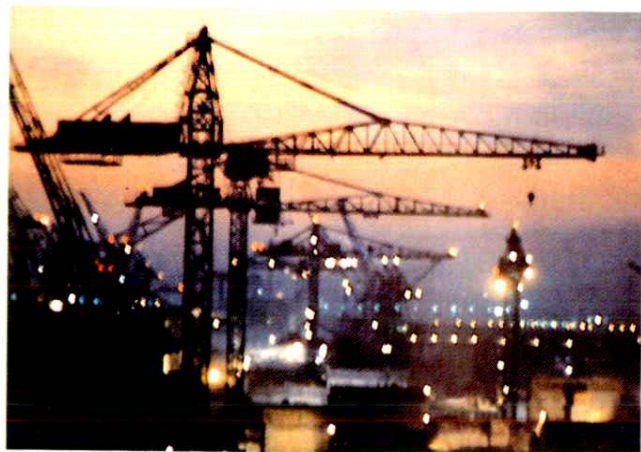
葛洲坝工程施工夜景
