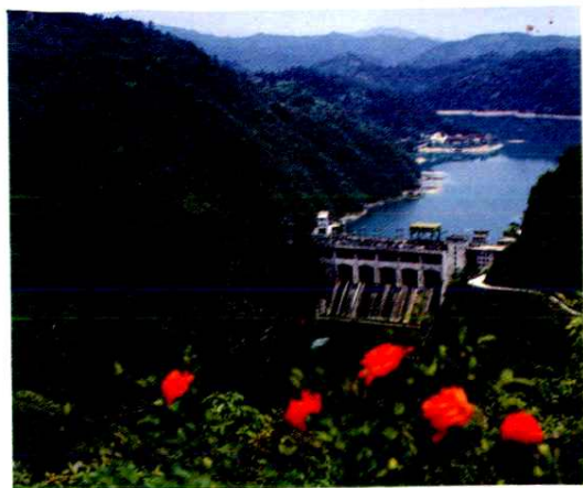
上犹江水电站，装机6万千瓦， 首台1.5万千瓦机组1957年10月投产
