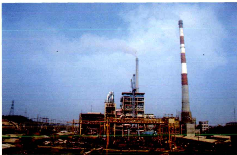
建设中的九江电厂
