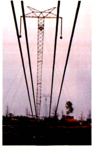
1987年，葛洲坝—上海 ±500千伏输电线路施工现场 李喜东摄
