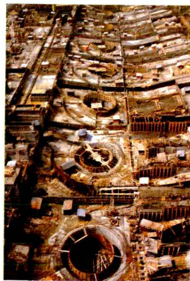
葛洲坝大江电厂机窝群
