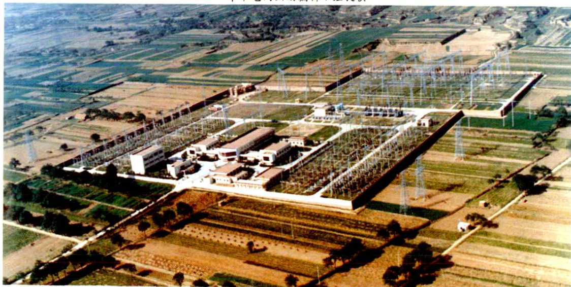
500 千伏郑州小刘变电站，主变压器容量 75 万千伏·安，1988 年 6 月投运
