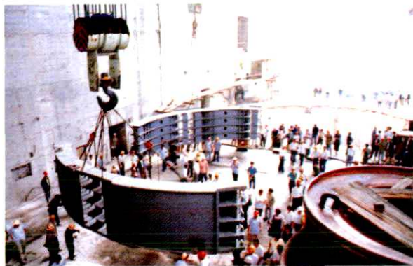
隔河岩水电站，总容量 120 万千瓦， 图为 30 万千瓦 1 号机组定子吊装 张祖诒摄
