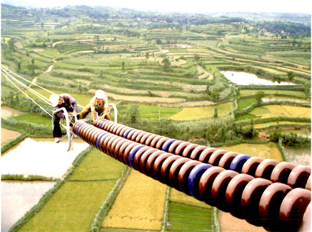
架线职工在葛上线工程高空作业
