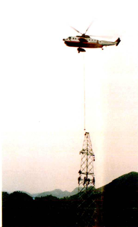
1987 年 5 月，湖北省电力建设三公司 在葛洲坝换流站接地极施工中采用
