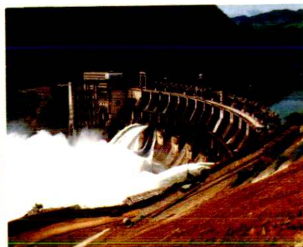
凤滩水电站，装机40万千瓦， 首台10万千瓦机组1978年5月投产
