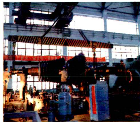
焦作电厂20万千瓦机组标准化大修
