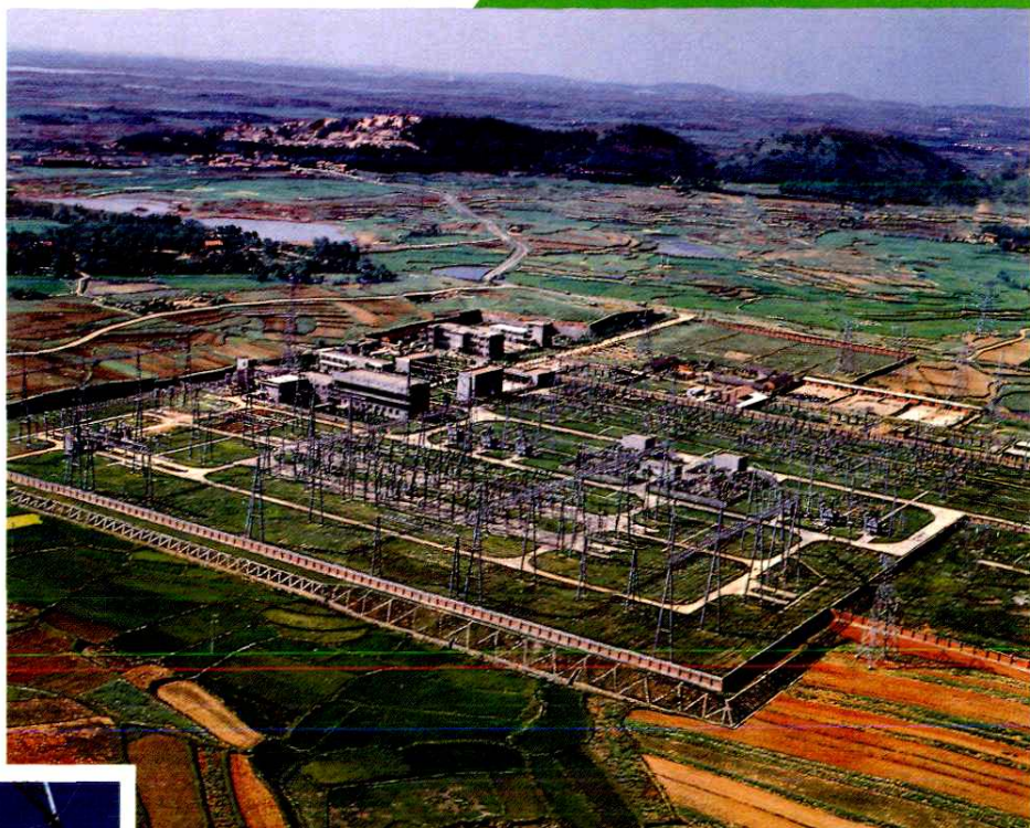
500 千伏武昌凤凰山变电站，主变压器容量 300 万千伏·安，1981 年 12 月投运
