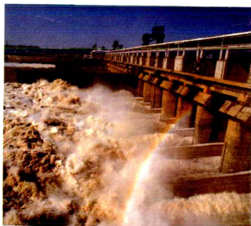
葛洲坝二江电厂排沙、泄水闸
