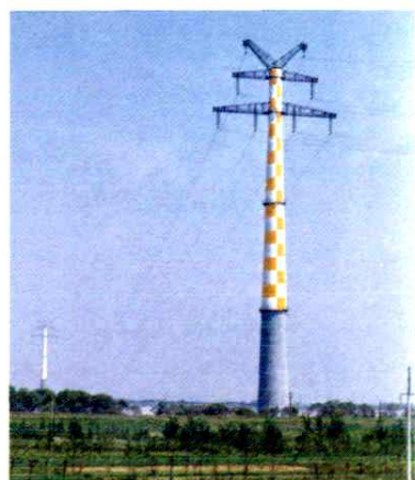
220 千伏输电线路长江沌口大跨越
