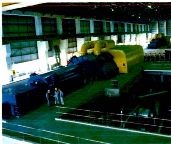
华能岳阳电厂，1988年开工， 首台36.25万千瓦机组1991年8月投产
