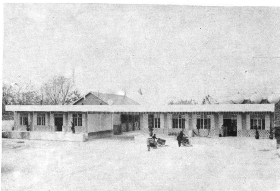
石油公司油库
