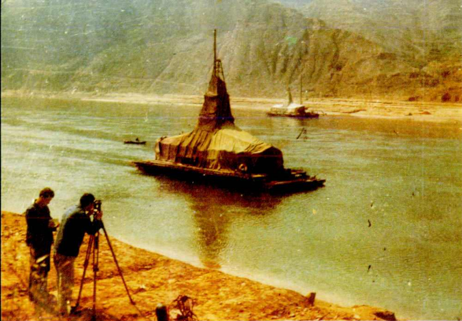
左图 1987 年黄委会地质勘探 人员在黄河小浪底 坝址进行水上勘探 (王新民摄)
