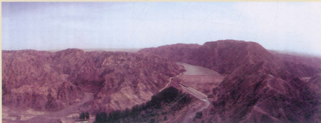
铁门关水电厂水库
