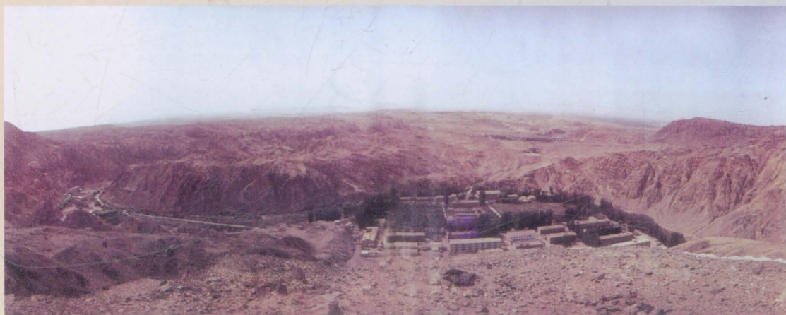
铁门关水电厂全貌
