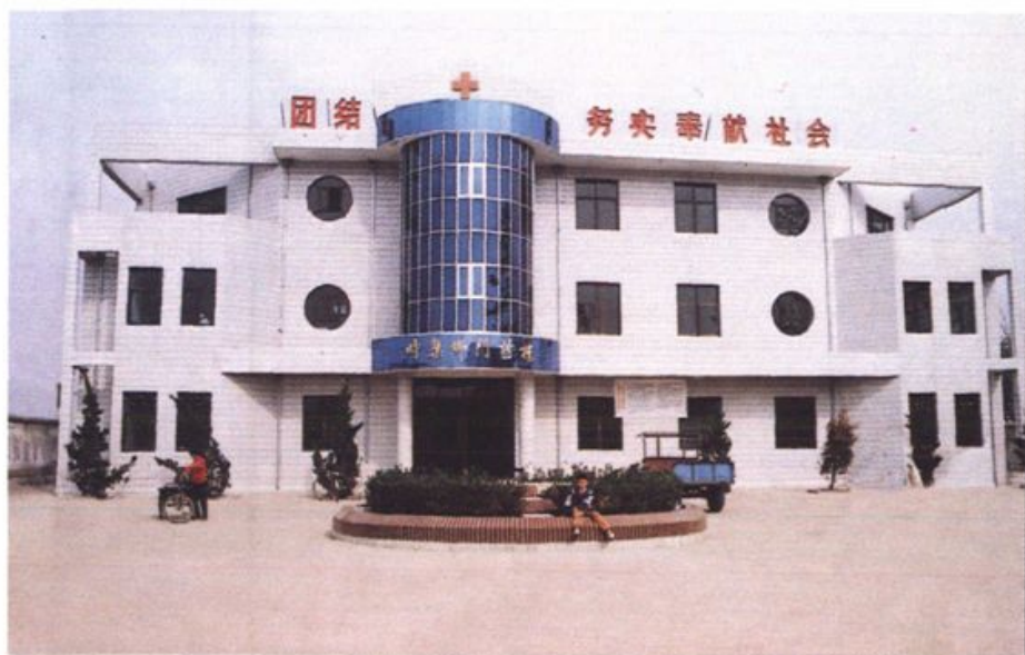
镇卫生院门诊楼
