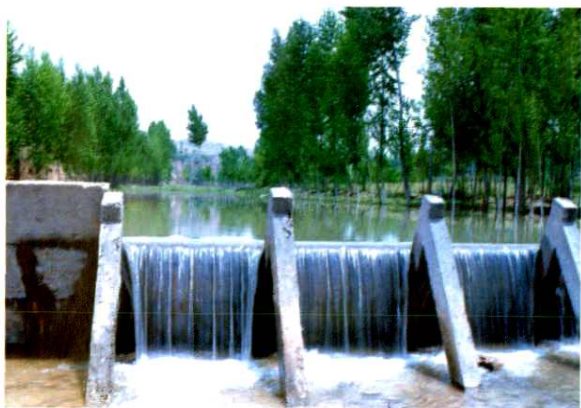
人字闸水利工程
