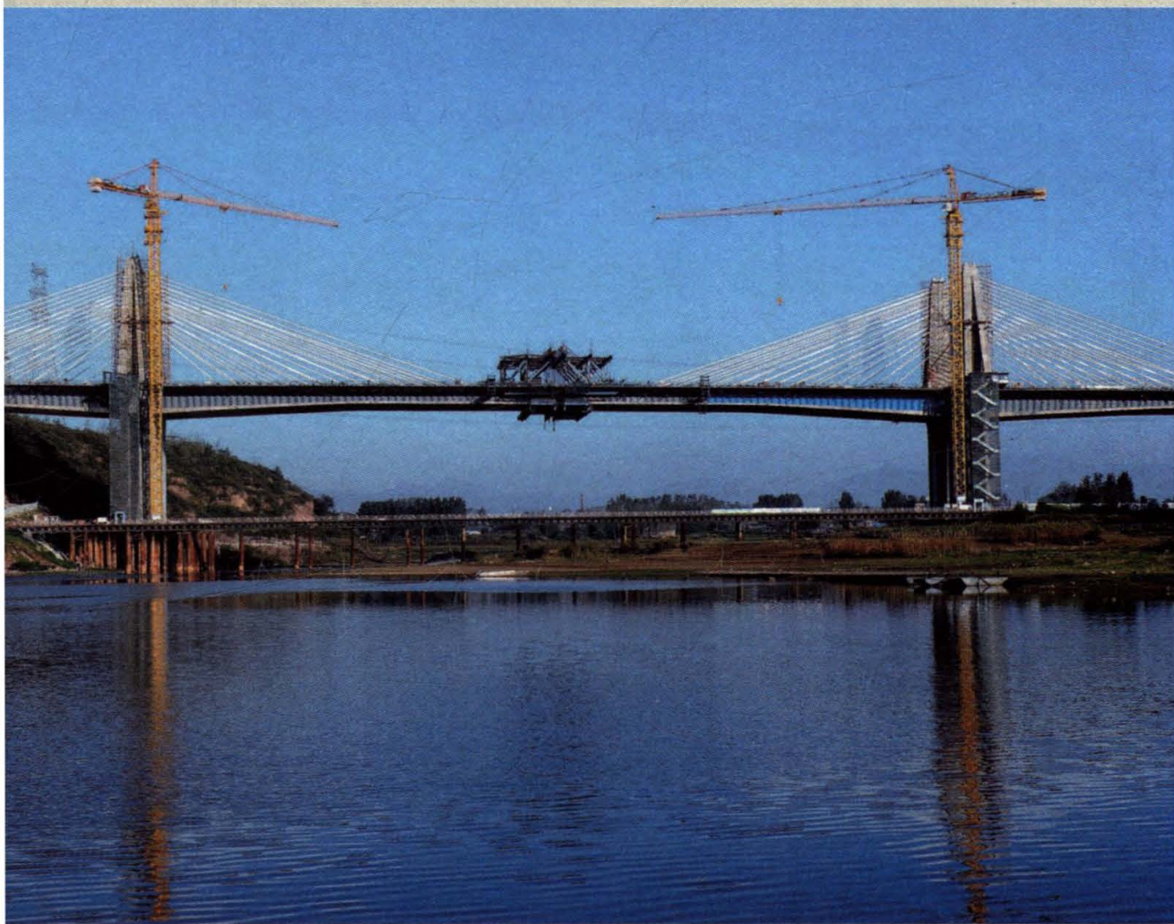
■ 2015年10月13日，郑登快速通道朝阳沟特大桥合龙
