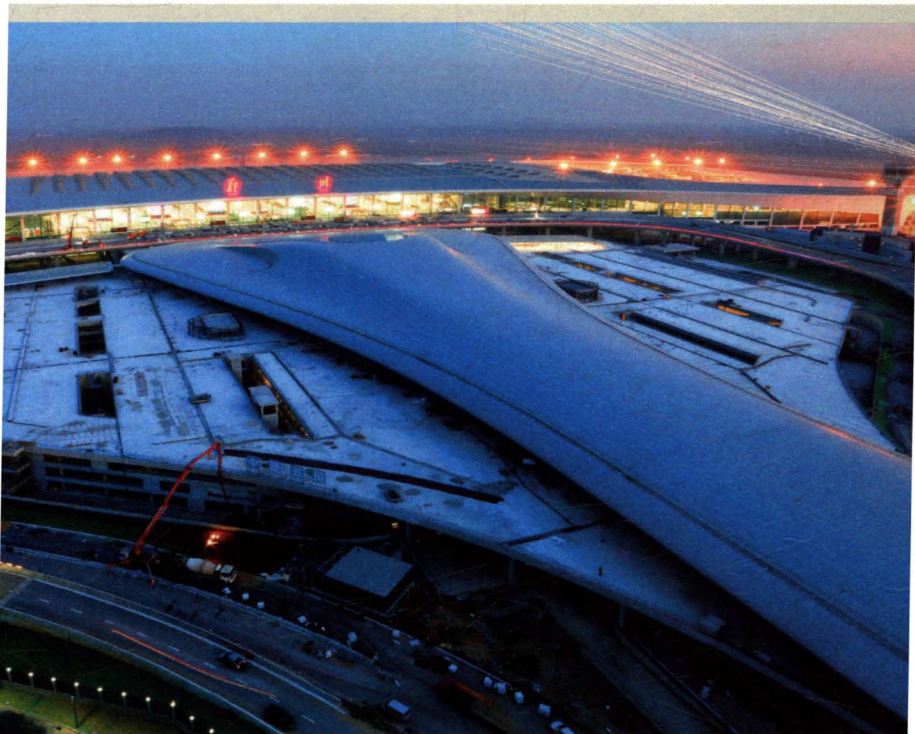
■ 2015年12月22日，郑州新郑国际机场二期扩建工程投运
