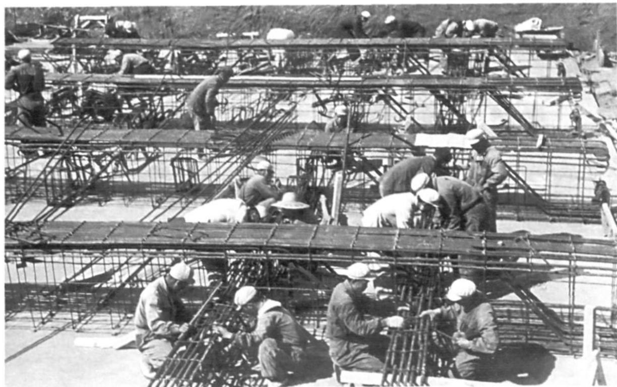
下 1954年，建筑五师战士在第一汽车制造厂工地绑扎钢筋
