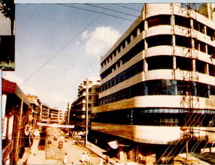
▼ 县建筑工程公司承建的百货公司大楼
