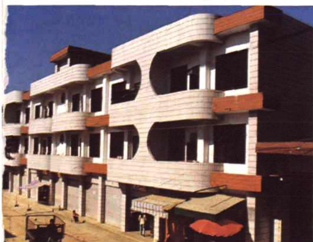
老城粮所办公大楼
