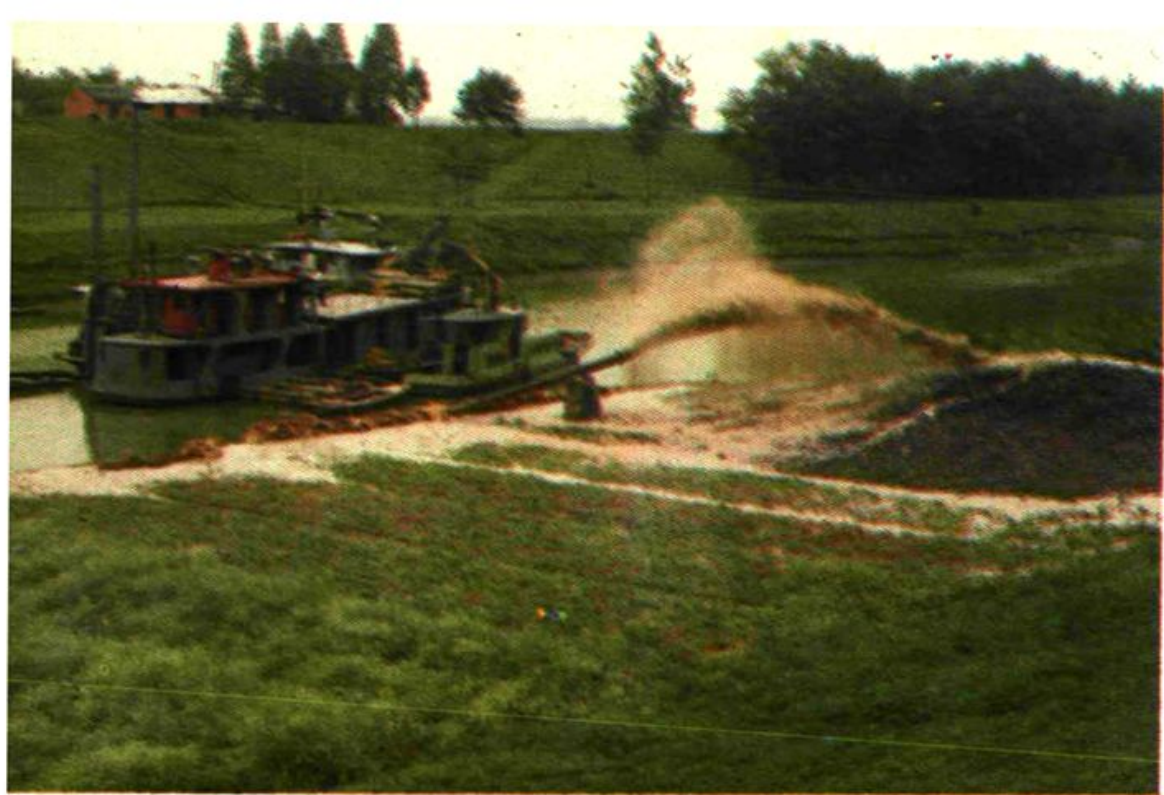
航务局挖泥船作业
