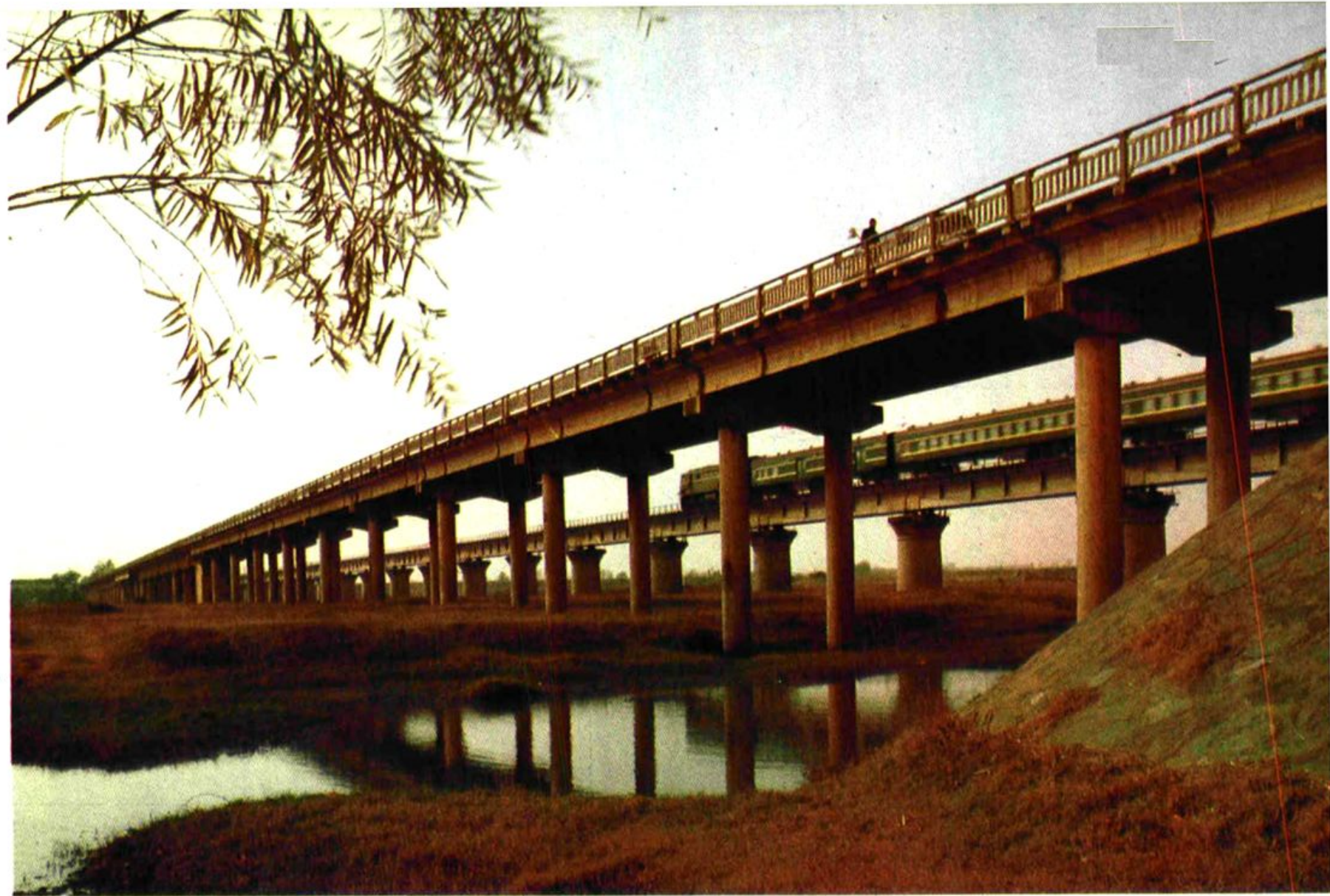
云梦隔蒲潭大桥
