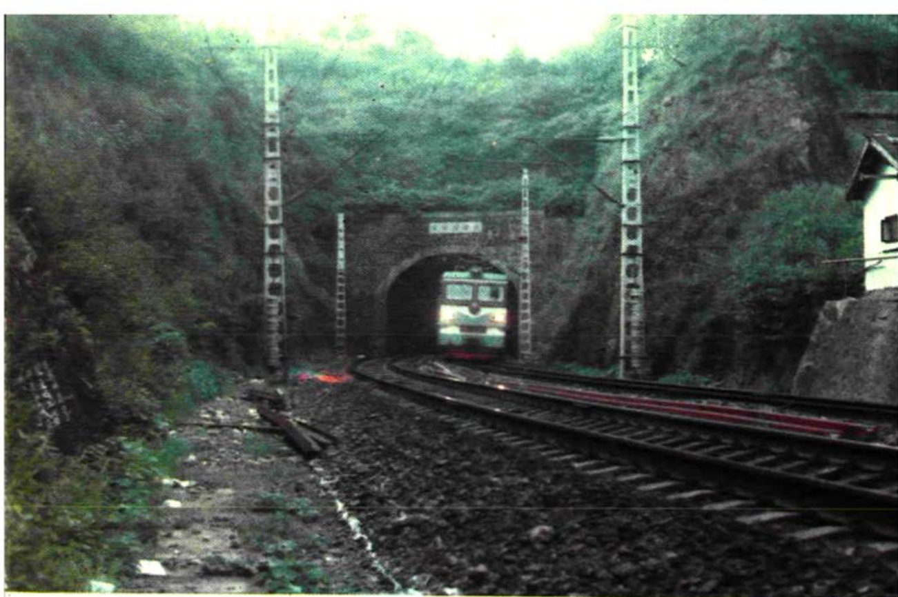
广水武胜关铁路隧道
