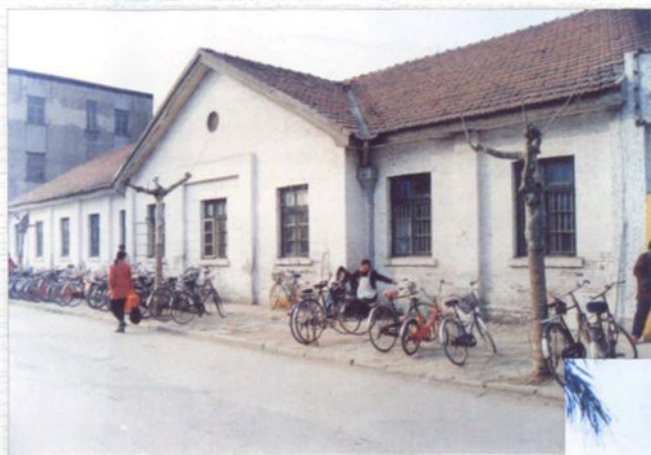
◎ 1960年建成的原门诊用房
