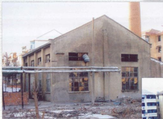
◎ 原医院锅炉房
