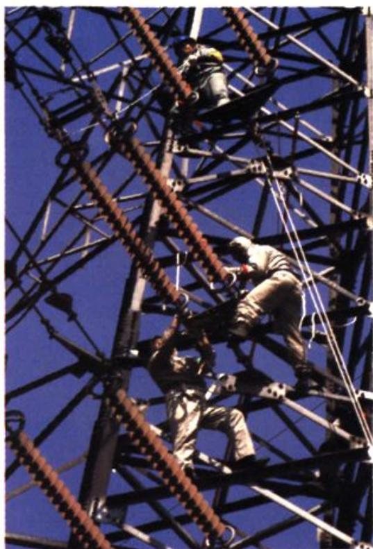
2006年输电工区带电作业
