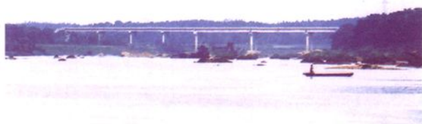
区境内 206 国道沙咀头大桥
