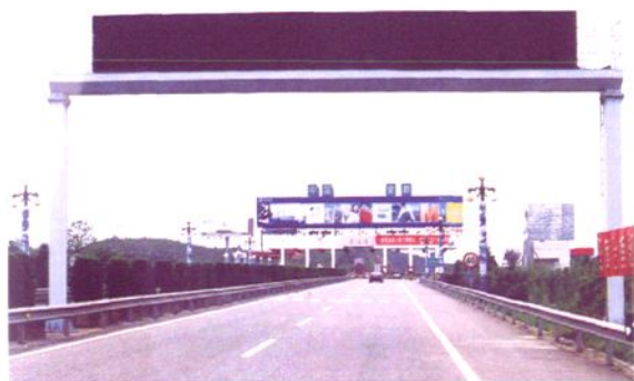
区境内九景高速公路
