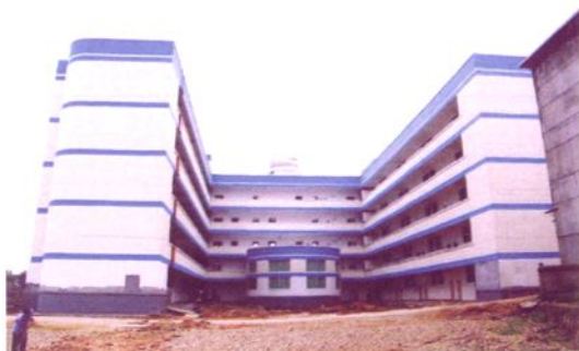
昌江一中科技大楼
