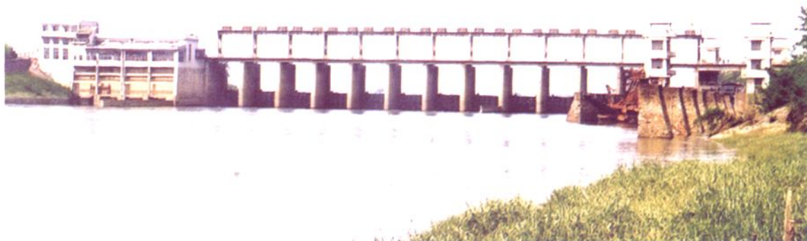
国家重点建设工程——鱼山渠化工程
