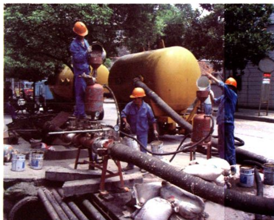
运用“旋转气流法”管道清垢涂膜修复技术，治理小区管道“黄水”
