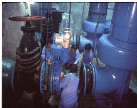
检修供水设施
