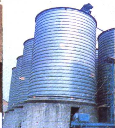
△沙河第二粮库钢板仓
