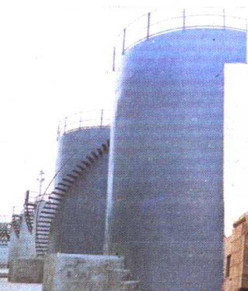
△沙河粮库储油罐
