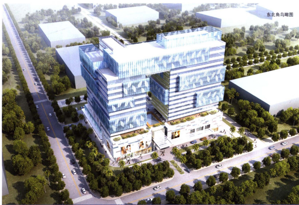
海口市御府国际幕墙工程
