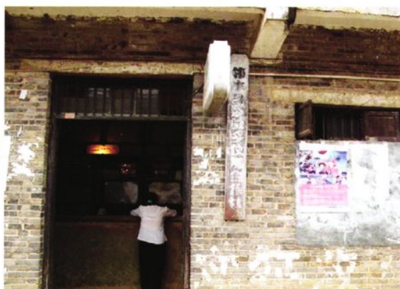
邻水县梁板信用社，其营业用房修建于上世纪70年代
