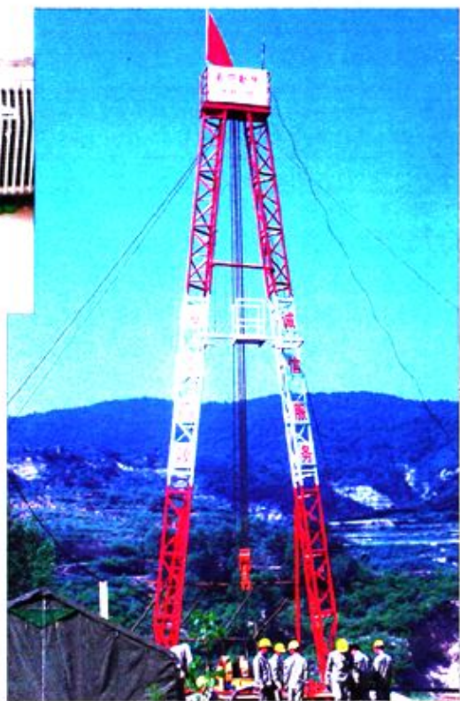
▶ 水井施工现场
