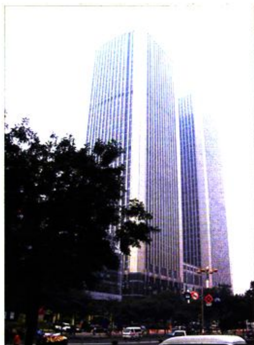
▲参与基础设施施工的山西国际贸易大厦新貌
