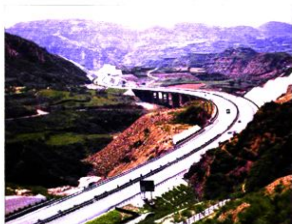
▲大运高速公路祁临段采空区工程施工区域
