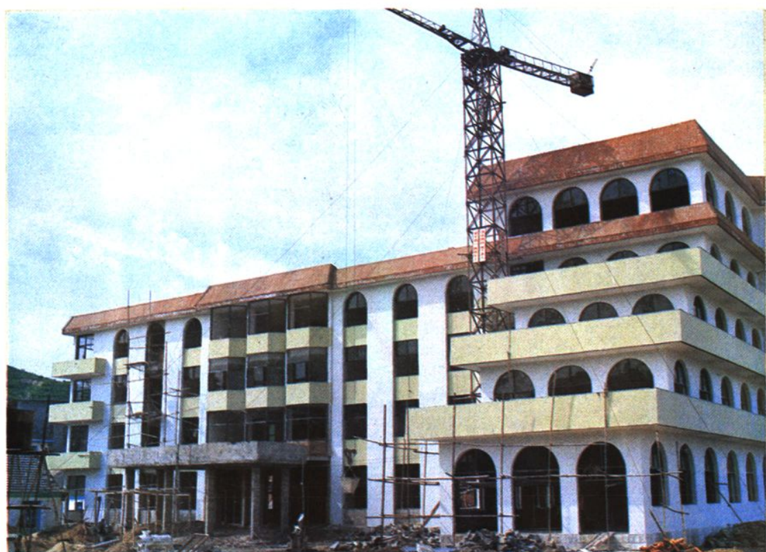
公路管理站办公楼
