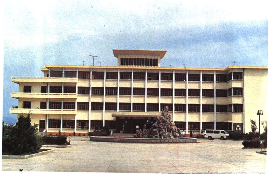
县委机关办公楼
